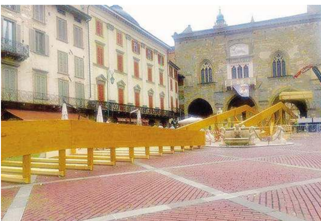
I lavori di costruzione della passerella di Stefan Tischer in Piazza Vecchia: la nostra natura torna in città
